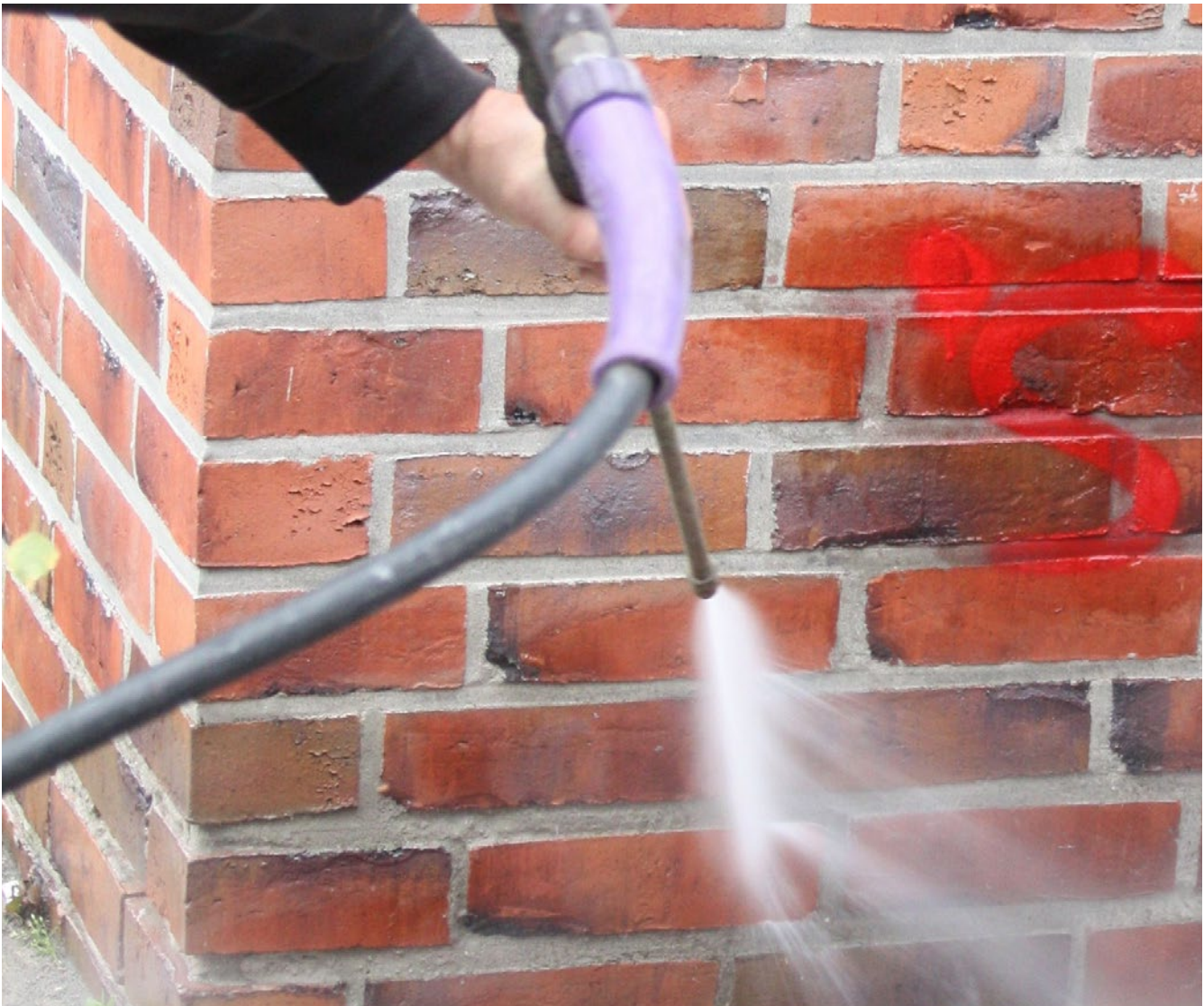
Auch Graffiti können mit Hilfe des neuen Farblösers leichter entfernt werden.
