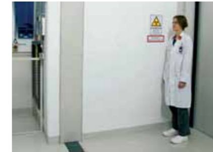
Die Außenwand des Reaktorgebäudes (hier die Außenwand an der Lkw-Schleuse) misst 1,80 Meter.
