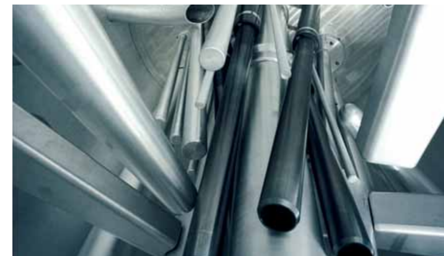
Anordnung der Abschaltstäbe im Moderatortank. In der Mitte der Zentralkanal mit dem Brennelement, darum herum schräg die Abschaltstäbe (hier drei zu sehen). Mehrere Strahlrohrnasen ragen in den hohen Neutronenfluss. Aufnahme aus der Bauphase.
